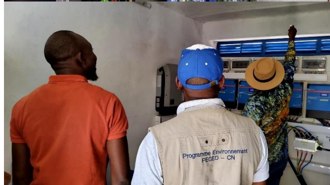
La mise en service Photo : Unité de Communication du PNUD
