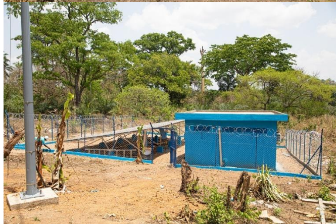
Les panneaux solaires
